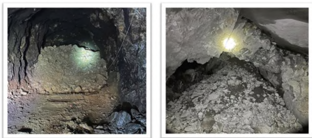
Slika 12. Zapunjavanje starih otkopa jamskim nemineralizovanim otpadom: otkop na V horizontu (levo) i komora na VIII horizontu (desno)
