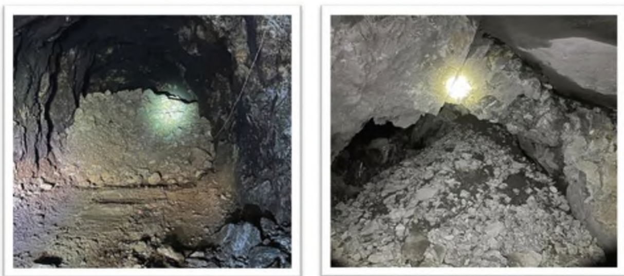
Slika 5. Zapunjavanje starih otkopa jamskim nemineralizovanim otpadom: otkop na V horizontu (levo) i komora na VIII horizontu (desno)
